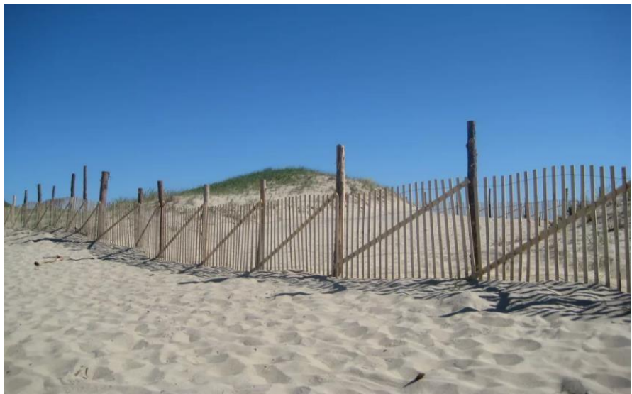
Gambar 3.4 Pagar pasir ditempatkan di sepanjang pantai di Cape Cod National Seashore, Massachusetts. Foto NPS oleh Georgia Hybels
