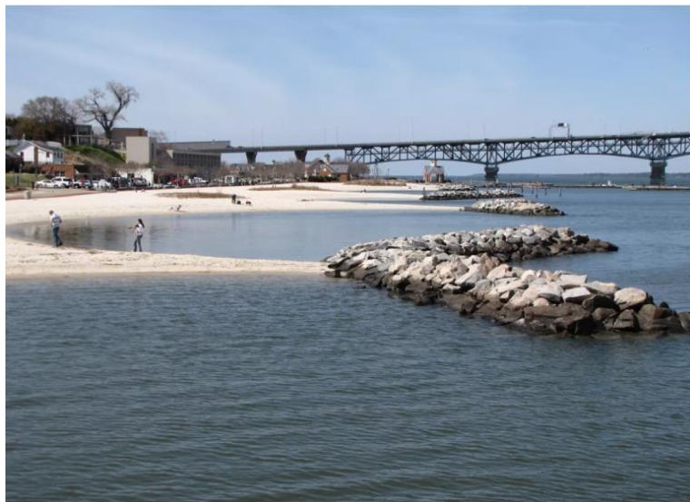
Gambar 3.7 Serangkaian pemecah gelombang mempromosikan akresi sedimen di Taman Sejarah Nasional Kolonial, Virginia. ( Sumber: Foto oleh Steve Simon, 2012 )
